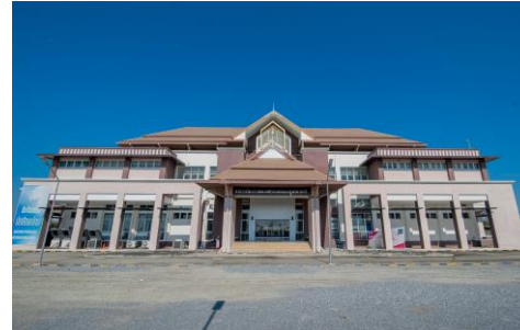
อาคารเรียนรวมอเนกประสงค์และศูนย์อาหาร
