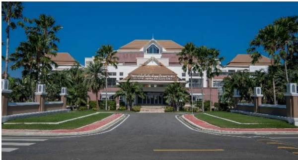
อาคารวิทยาลัยโลจิสติกส์และซัพพลายเชน
